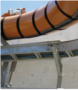
TT5000 HUV under pipe
